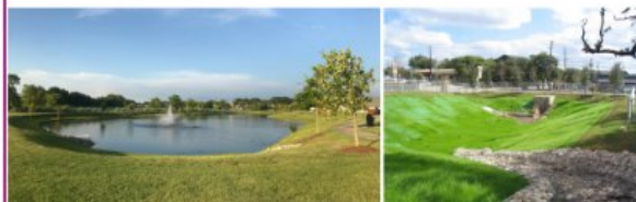
Basses de retenció/infiltració
